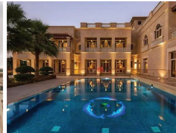
Dubai Apartments Project 迪拜公寓项目
